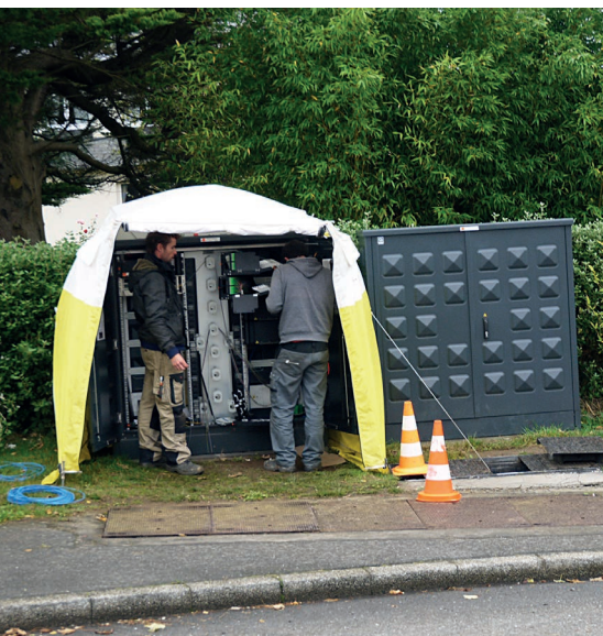
Installation d'une armoire de distribution, rue de Brest.
